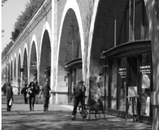
Viaduc des Artes -
